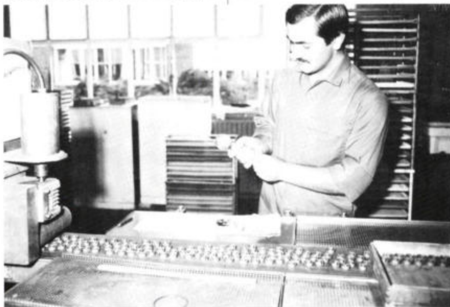
Dimensiecontrole van keramische potkernen (foto Philips).
