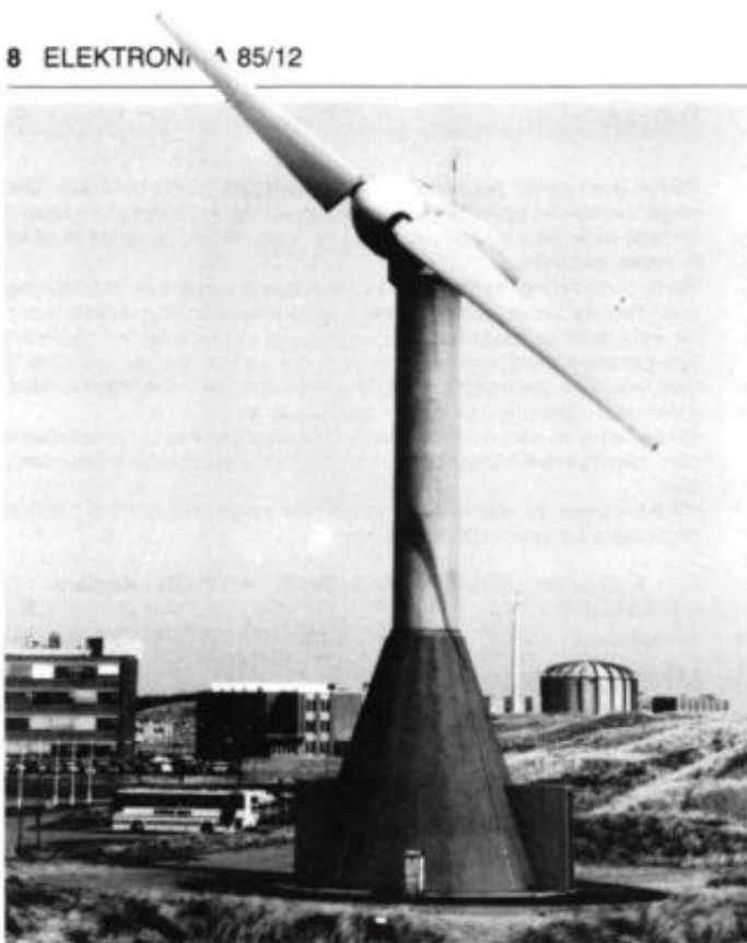
In dit land van windmolens is een record gevestigd: de grote windturbine van het ECN heeft de 10 000 uur in automatisch bedrijf overschreden. Daarmee heeft deze turbine, met een rotordiameter van 25 meter en een vermogen van 300 kW, een grote voorsprong genomen op alle andere grote en kleine windturbines, waar ook ter wereld. Sinds de turbine in juli 1982 in gebruik is genomen, heeft hij 680.000 kWh aan het elektriciteitsnet geleverd, hetgeen voor een onderzoekapparaat een respectabele hoeveelheid energie is.
